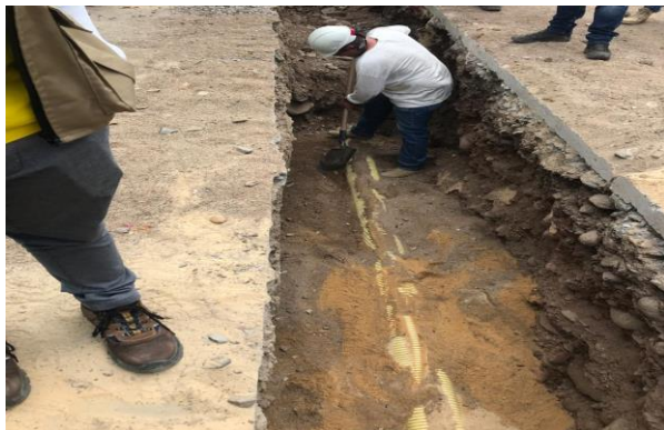
INSTALACION DE TUBERIA SANITARIA Y CAMA DE ARENA, RELLENO EN RECEBO Y MATERIAL DE RELLENO SELECCIONADO PRODUCTO DE EXCAVACION
