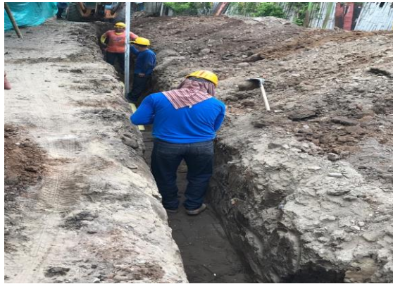
NIVEL TOPOGRAFICO PARA INSTALACION DE TUBERIA SANITARIA
