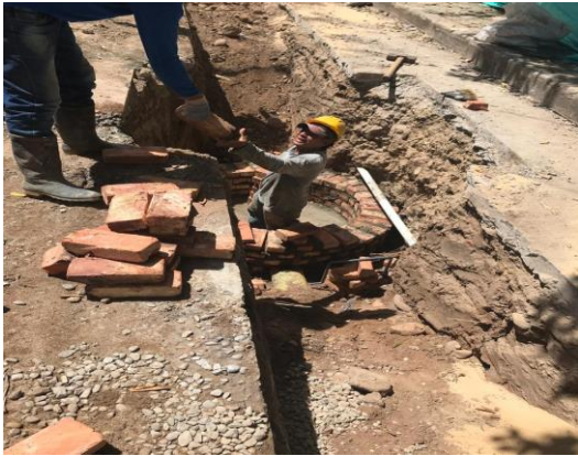
CONSTRUCCION DE POZO DE INSPECCION
