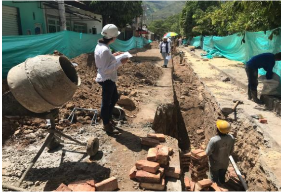
VERIFICACION DE CONSTRUCCION DE POZO DE INSPECCION E INSTALACION DE RED SANITARIA
