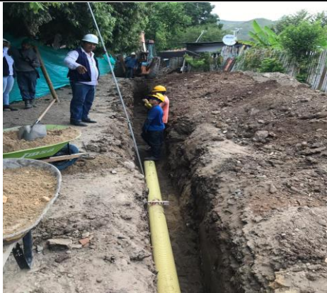
INSTALACION DE TUBERIA SANITARIA
