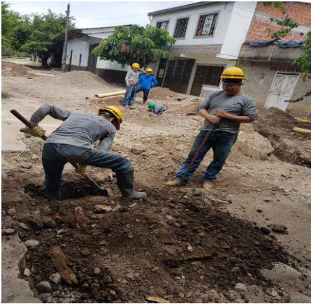
EXCAVACION PARA RED DOMICILIARIA
