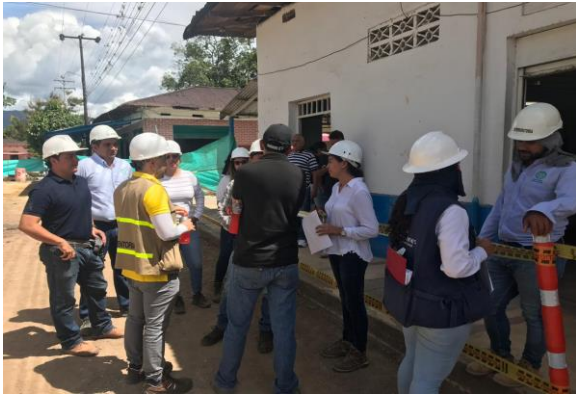
VISITA DE SUPERVISION DE OBRA
